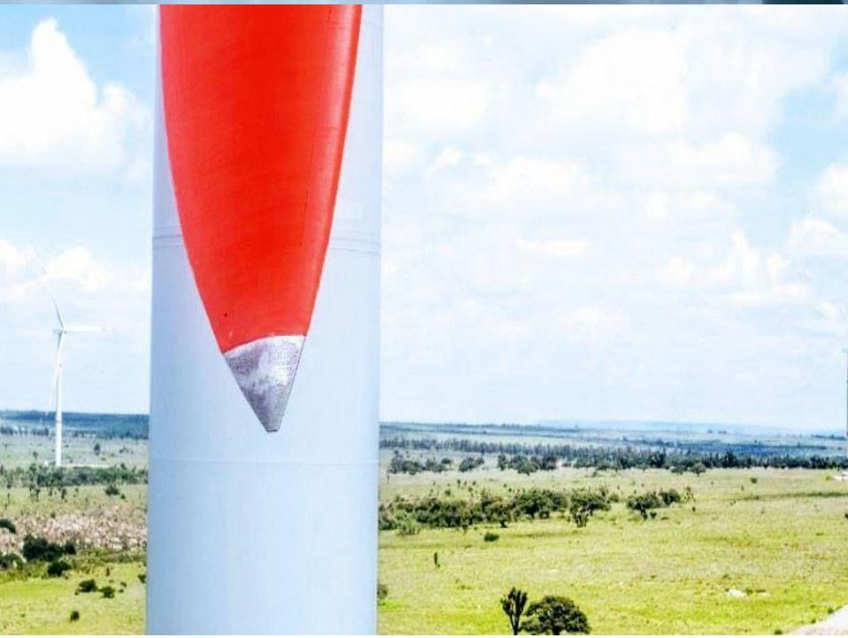
El dron M210 RTK emplea un promedio de 30 minutos en la inspección de las tres palas de cada turbina eólica.
